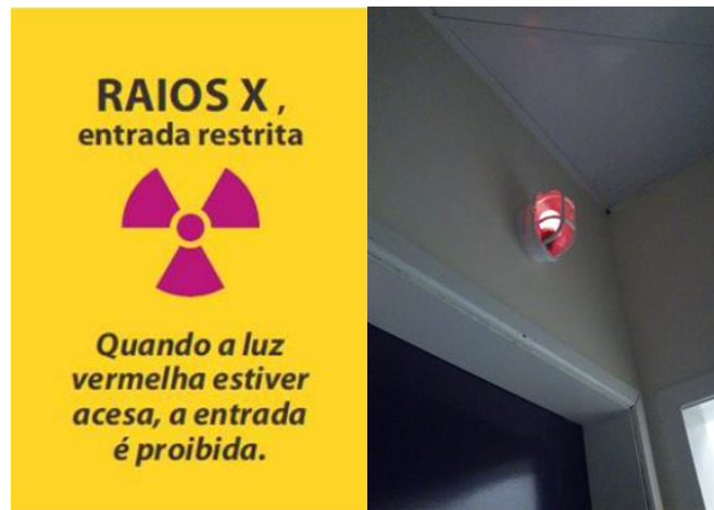
Figura 4: Sinalização de área controlada nas portas das salas de exames com uso de raios X. Fonte: o Autor.
