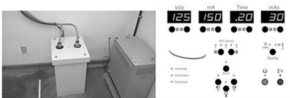
Figura 18: Gerador (esquerda) e mesa de comando(direita): Fonte: deanradiologia.blogspot.com
